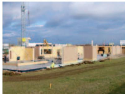
Les murs et les planchers ont été préfabriqués en atelier. Les travaux n'ont ainsi pas dû être interrompus en hiver, et la construction du bâtiment n'a duré que 10 mois.
