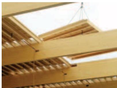
Les éléments préfabriqués sont mis en place à l'aide d'une grue.
