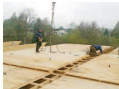
Les charpentiers se chargent de l'assemblage des éléments de toiture.
