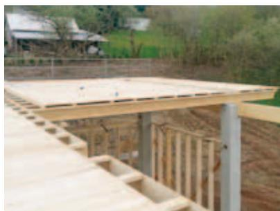
Réalisation d'éléments de grande portée grâce à la légèreté des poutres STEICOjoist
