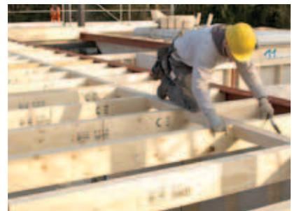
Les toitures devant supporter des charges élevées sont construites directement sur le chantier avec les poutres STEICO LVL.
