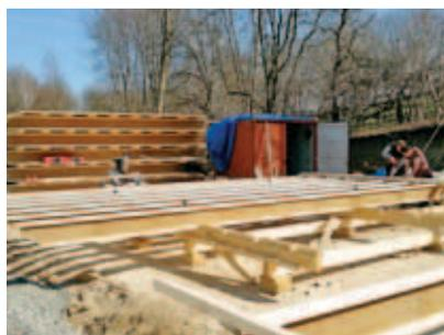
Les poutres en I STEICOjoist ont été livrées prédécoupées et ont été assemblées sur place aux éléments de toiture.
