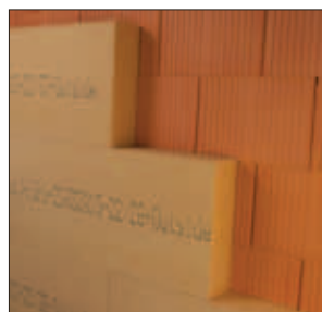
Montage de panneaux petit format à chants droits
