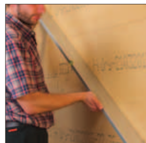
Vérification de la planéité
