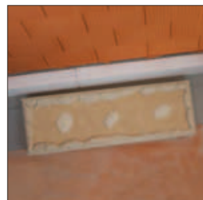
On applique un cordon de colle périphérique et des plots au milieu du panneau.
